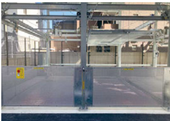
1 ゲート | 人や車の侵入を防止するため装置前面に各連ゲートを設置しています。
