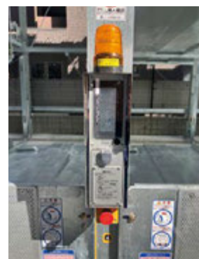
7 操作盤(タッチパネル) 安全確認ボタン 非常停止ボタン(赤)
