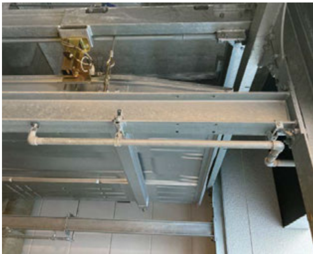
泡消火配管取付 (建築工事)
