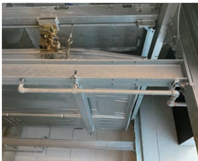
泡消火配管取付(建築工事)
