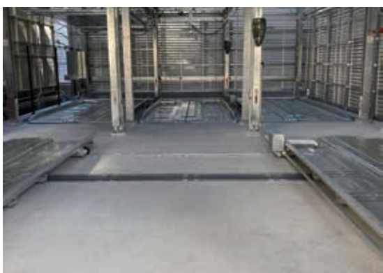
通路(地上縦列)
