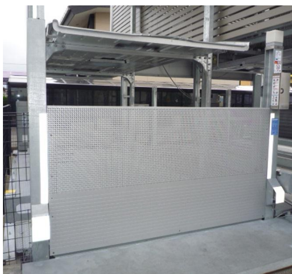
水害対策機能付きゲートの写真
