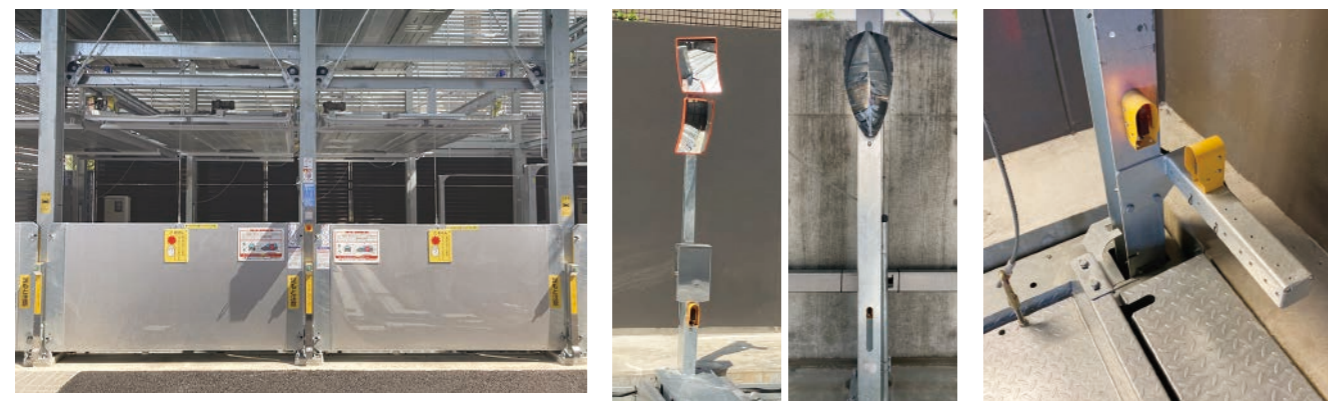
1 ゲート | 人や車の侵入を防止するため装置前面に各連ゲートを設置しています。 2 | 後部確認ミラー 3 | 区画検知センサ(後)
