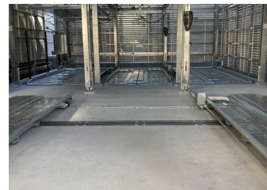
通路(地上縦列)
