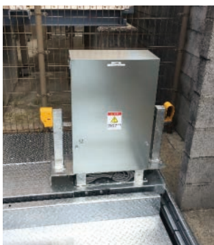
制御盤／区画検知
