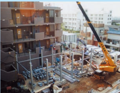
(自社施工管理)
