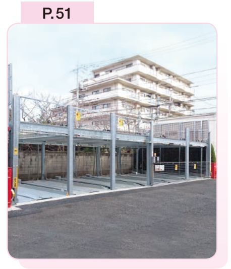
LTZ20 昇降横行式地上式2段 レクセルピットパズル20 (地上2段)
